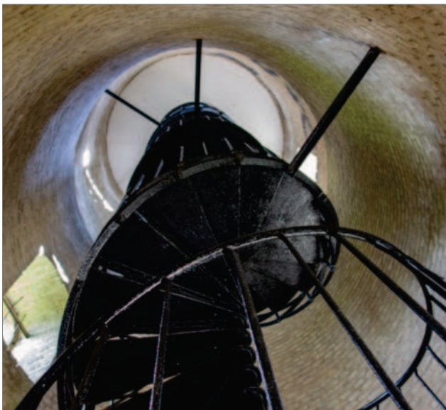
Obr. 3-3: Uvnitř cihlové rozhledny vedou k vyhlídkové plošině železné točité schody. / Im Inneren des aus Ziegeln gemauerten Aussichtsturms führt eine eiserne Wendeltreppe zur Aussichtsplattform.
