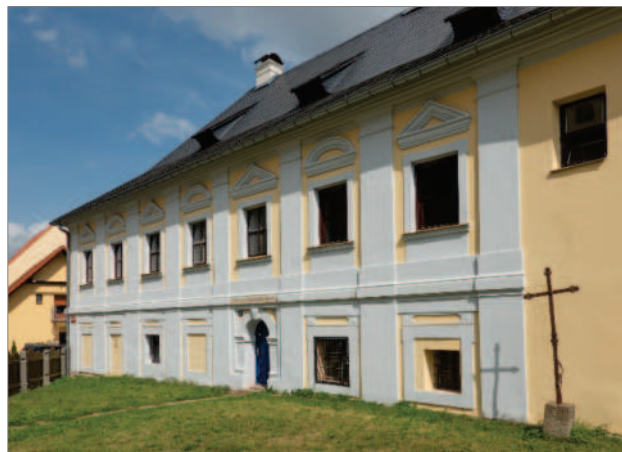
Obr. 3-62: Západní fasáda severojižního křídla fary, postaveného podle chronogramu v roce 1707, s kovaným železným křížem na žulovém podstavci. / Westfassade des laut Chronogramm 1707 errichteten Nord-Süd-Trakts des Pfarrhofs mit einem geschmiedeten Eisenkreuz mit Granitsockel.
