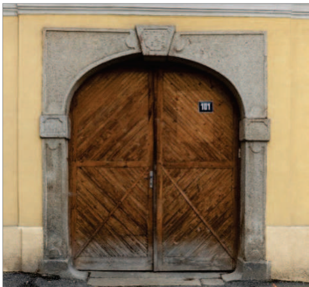
Obr. 3-9: Portál domu čp. 101 v ulici Dukelských hrdinů z jemnozrnné žuly. / Granitportal am Gebäude Nr. 101 in der Dukelských hrdinů-Straße aus feinkörnigem Granit.
