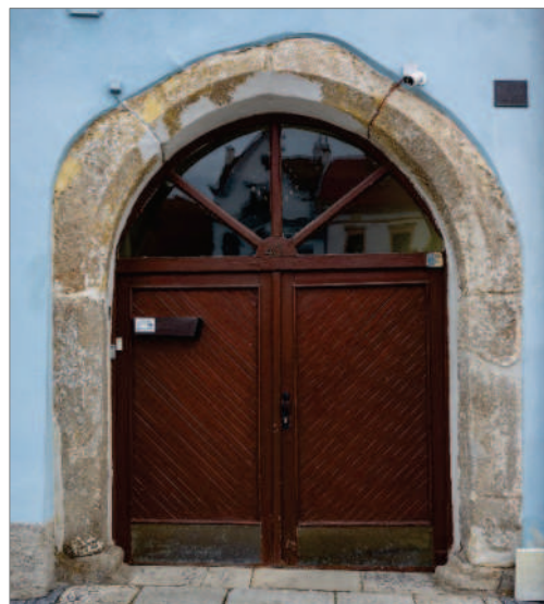
Obr. 3-33: Dům čp. 40, gotický portál ze světlé žuly. / Haus Nr. 40, gotisches Portal aus hellem Granit.
