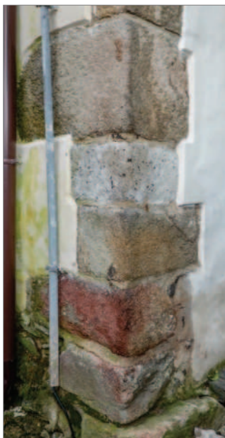
Obr. 3-7: Rohové kameny ze žuly a světle šedého trachytu s černými dendrity oxidu manganu na severozápadním rohu budovy kostela. / Eckblöcke aus Granit und hellgrauem Trachyt mit schwarzen Manganoxid-Dendriten an der Northwest-Ecke des Kirchengebäudes.
