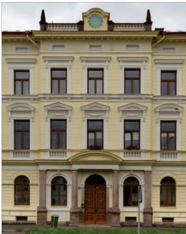
Obr. 3-11: vlevo a vpravo - centrální rizalit fasády bývalé budovy spořitelny s žulovými sloupy a pilíři v oblasti portálu. / links und rechts - Mittelrisalit der Fassade des ehem. Sparkassengebäudes mit Granitsäulen und -pfeiler im Portalbereich.
