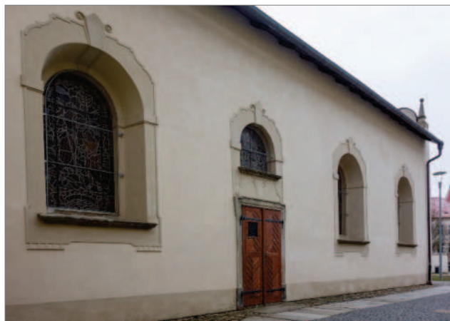
Obr. 3-39: Barokní přístavba na severní straně kostela s barokními okenními a dveřními rámy z porfyrické žuly. / Barocker Anbau im Norden der Kirche mit barocken Fenster- und Türegewänden aus porphyrischem Granit.
