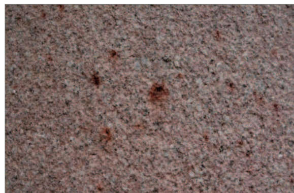
Obr. 3-12: Detail povrchu žuly se zbytky červené barvy. / Detail der Granitoberfläche mit Relikten der roten Farbfassung.
