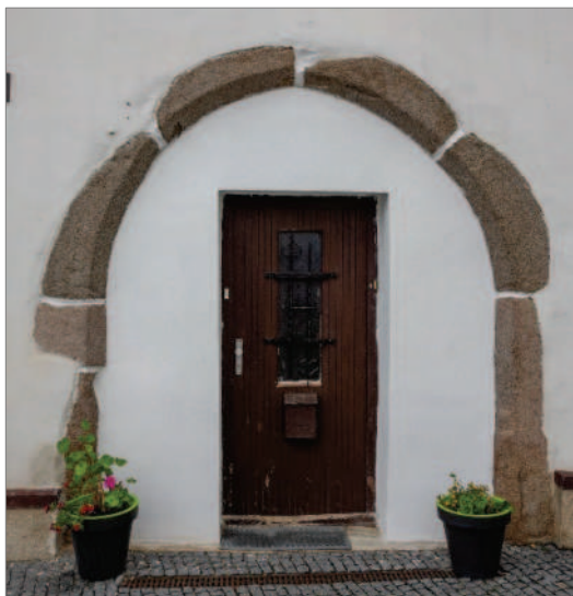
Obr. 3-31: Dům čp. 30 s gotickým žulovým portálem, který byl odkrytý při restaurování. / Haus Nr. 30 mit gotischem Portal aus Granitsteinen, die nach der Restaurierung freigelegt wurden.
