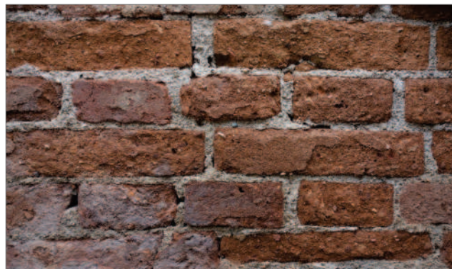
Obr. 3-18: Typické zdivo z ručně vyrobených hrubých cihel. / Typisches Mauerwerk aus handgeschlagenen Ziegeln mit grober Magerung.
