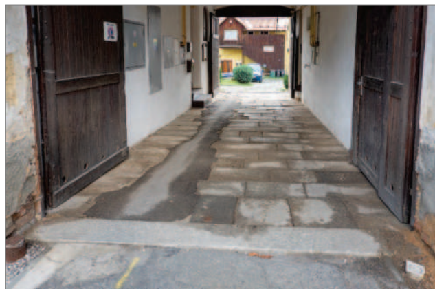
Obr. 3-8: Velké „rovnné desky“ jako dlažba průjezdu domu čp. 99 na Petrském předměstí. Tyto desky pocházejí z těžby z kamenných kup a lomů západně od Plané. / Große „Gredplatten“ als Pflaster in der Durchfahrt des Gebäudes Nr. 99 in der Petersvorstadt. Diese Platten stammen aus den Abbauen in Steinhalden und in den Steinbrüchen westlich von Planá.
