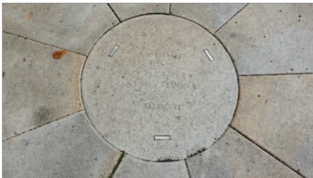
Obr. 4-10: Detail prostředního žulového kamene s popisem „staré studny“. / Detail der zentralen Granitscheibe mit der Beschriftung des „alten Brunnens“.
