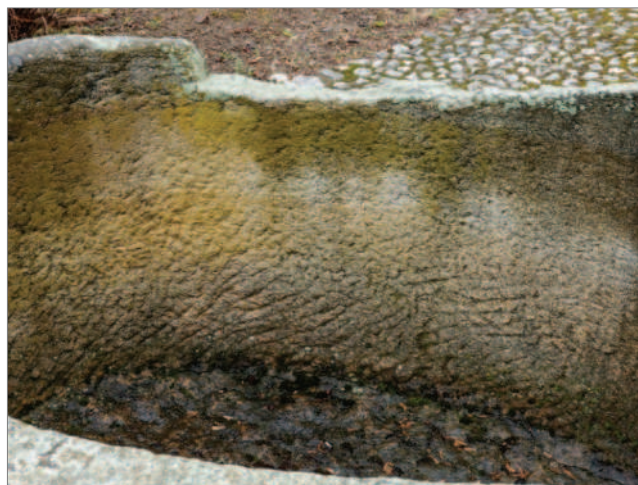
Obr. 4-25: Stopy opracování kamene na vnitřní stěně vodního žlabu, které svědčí o vyhloubení monolitického bočníkovitého balvanu z hrubozrnné žuly. / Bearbeitungsspuren an der Innenwand des Wassertrogs, die vom Aushöhlen des monolithischen „Wollsack“-Blocks aus großkörnigem Granit herrühren.
