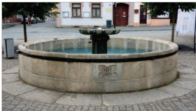
Obr. 4-15: Boční pohled na kašnu s letopočty obnovy příp. opravy. / Seitenansicht des steinernen Röhrkastens mit den Jahreszahlen der Erneuerung bzw. Renovierung.
