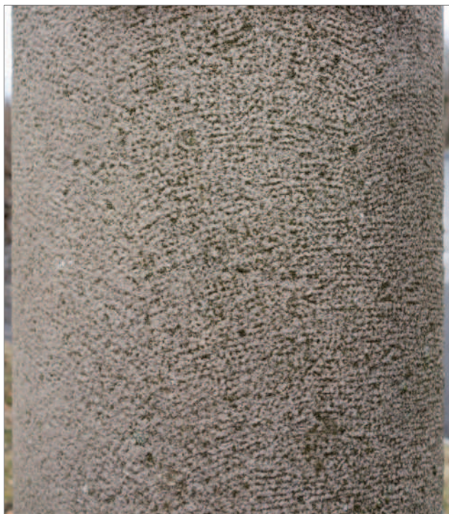
Obr. 5-4: Jemně obloukovitě štokovaný povrch sloupu z tepelského trachytu. Tento druh opracování je známý z kamenů zdi klášterního kostela v Teplé, zhotovených kolem roku 1930. Šířka obrazu cca 20 cm. / Feingestockte Oberfläche des Teplá-Trachyts des Säulenschaftes. Diese Bearbeitungsform ist von den um 1930 gefertigten Blöcken der Kirchenfassade der Stiftskirche von Teplá bekannt. Bildbreite ca. 20 cm.
