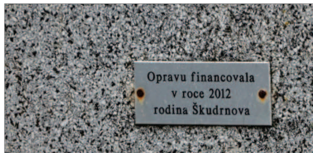
Obr. 7-9: Umělý kámen božích muk je tvořen cementovou matricí se zrny mramoru a čediče. / Der Kunststein des Bildstocks besteht aus einer Zementmatrix mit Zuschlagskörnern aus Marmor und Basalt.
