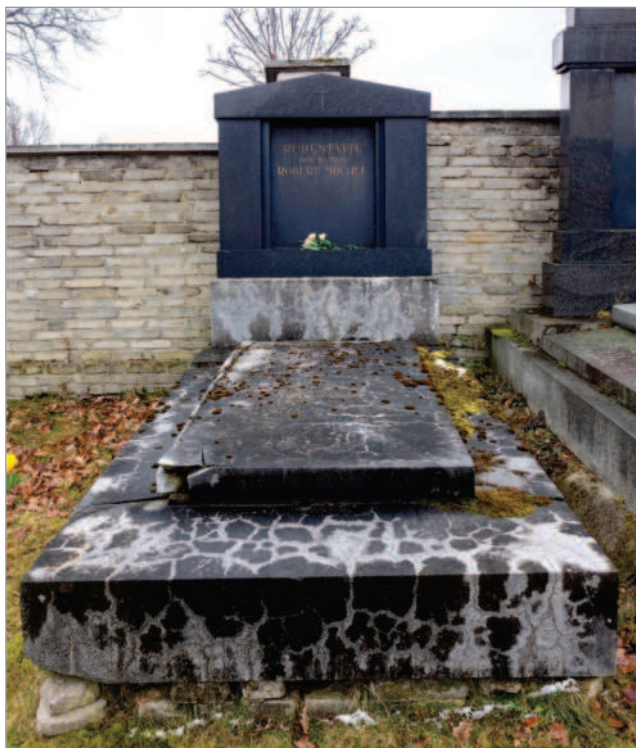
Obr. 8-10: Hrobka rodiny MÖCHEL u západní hřbitovní zdi. Z úlomku kamene z poškozeného levého předního rohu menší desky byl zhotoven broušený preparát. / Gruft von Familie MÖCHEL an der westlichen Friedhofsmauer. Von der beschädigten linken, vorderen Ecke der kleineren Grabplatte wurde von einem abgegangenen Steinsplitter ein Schliffpräparat angefertigt.
