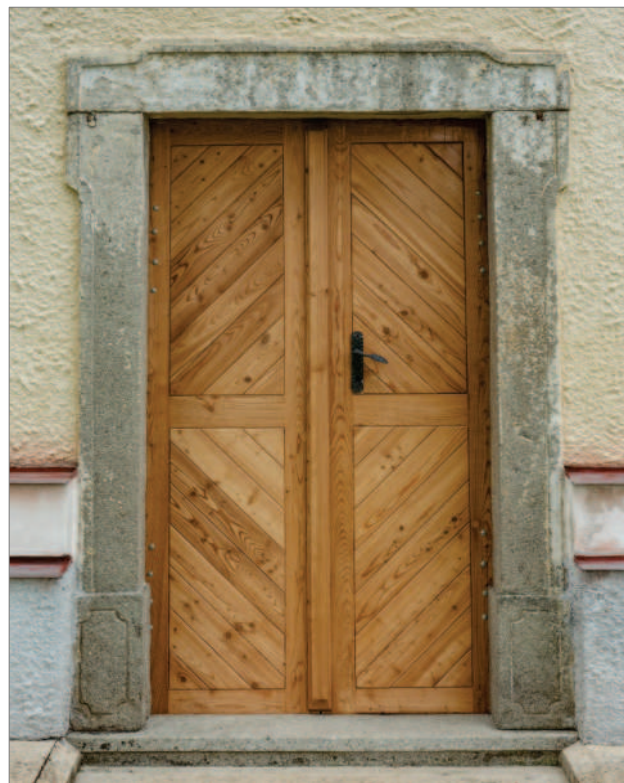
Obr. 9-7: Na západní straně je barokní žulový portál. / An der Westfassade befindet sich ein barockes Granitportal.
